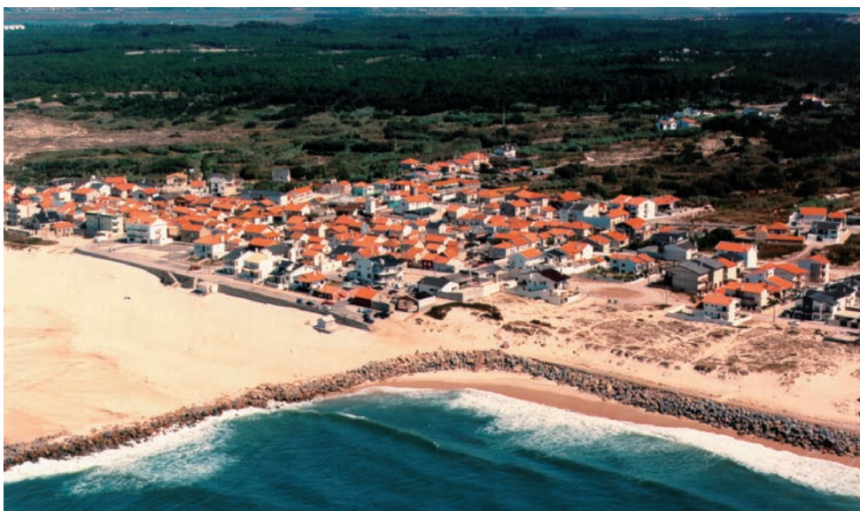
Foto 10: Esporão transversal para retenção de areia a barlar na frente da povoação da Costa de Lavos. A erosão a sotamar e a expansão urbana levou à construção de muro frontal de protecção da estreita frente dunar, com forte efeito destrutivo da praia.
