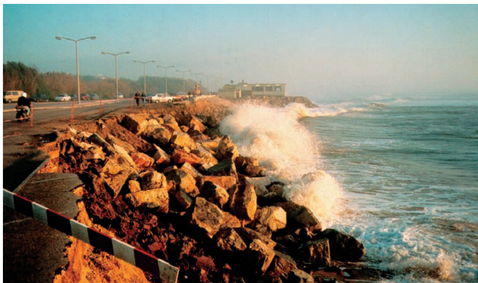
Foto 9: Poder destruidor das vagas sobre muro de protecção na marginal oceânica da Figueira da Foz (12/10/1996).
