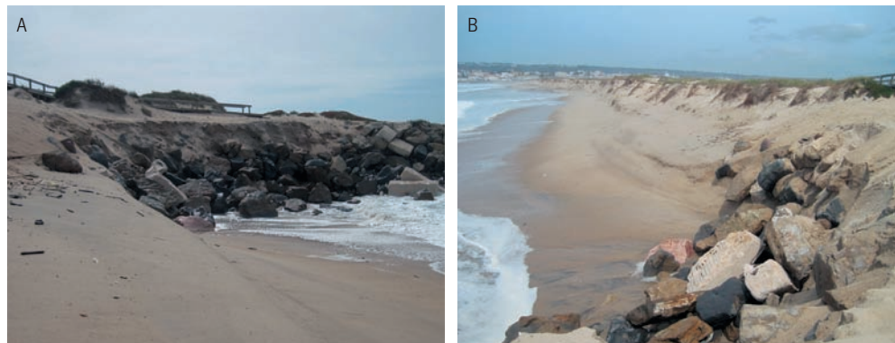
Fotos 11A e 11B: Impacto de um período de ondulação de SW sobre a face norte de um esporão e a zona contígua de praia e duna frontal da região centro oeste portuguesa (Cova-Gala, em 27/03/2010).
